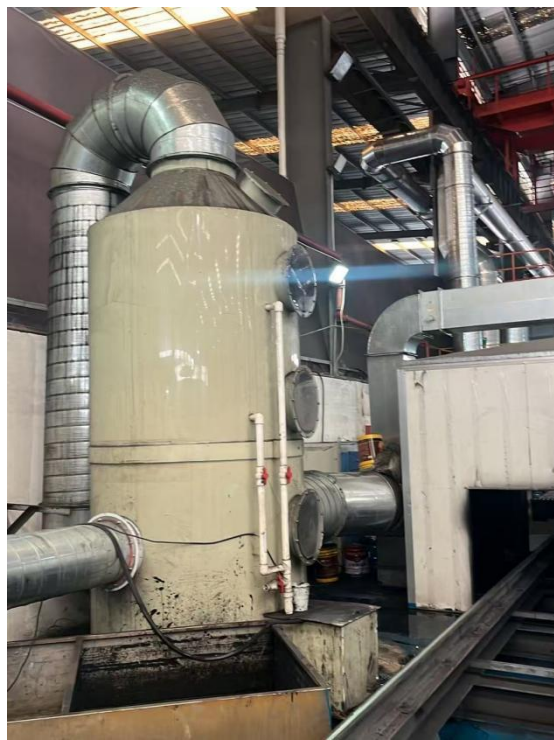
集气罩（1个）+“喷淋塔+UV 光氧净化+活性炭吸附”
