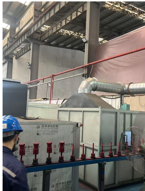
集气罩（1个）+“喷淋塔+UV 光氧净化+活性炭吸附”
