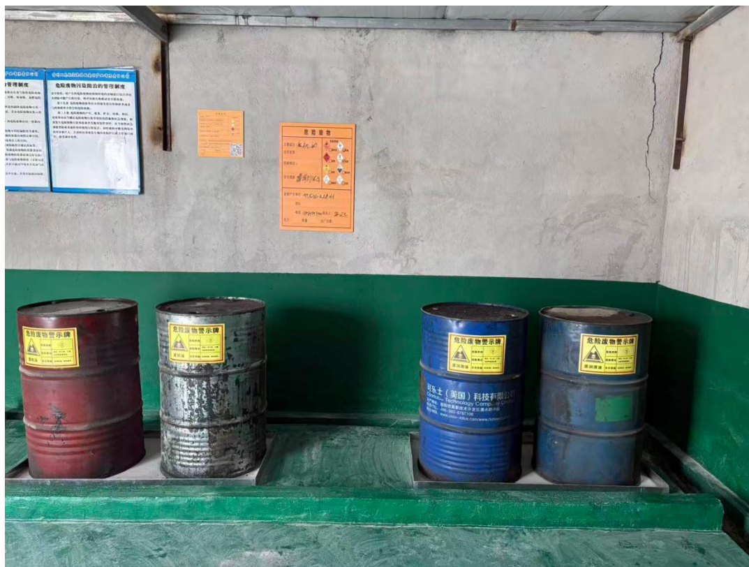
危险废物暂存间
