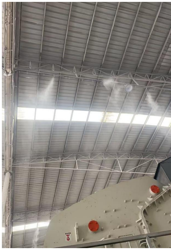
厂房洒水降尘
