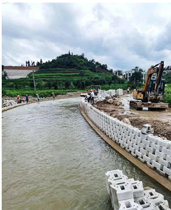
现场施工照片
