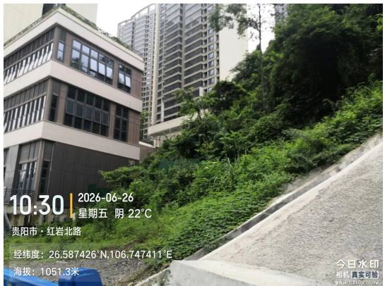
施工结束后边坡绿化
