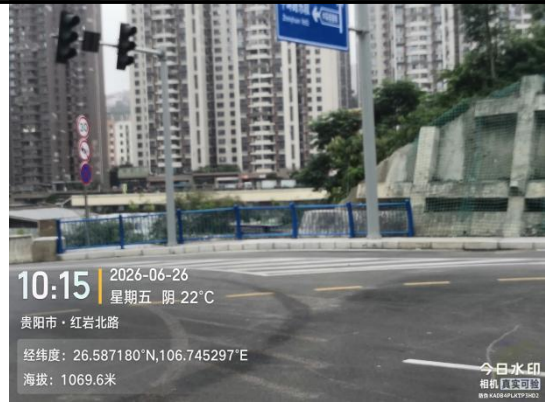
沉淀池施工结束后恢复现状
