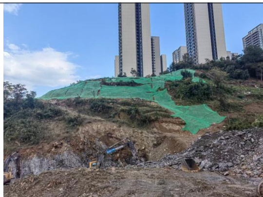
施工期道路两侧
