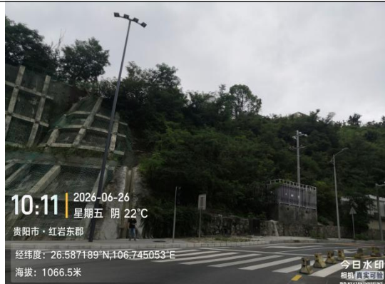
恢复后的堆材区1#
