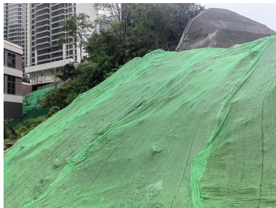
施工期边坡防护
