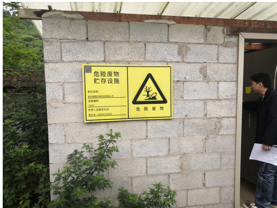
危险废物暂存间
