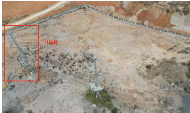
附图 7 塔基现场照片
