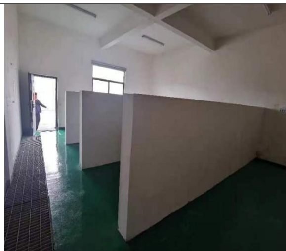
危废暂存间现状
