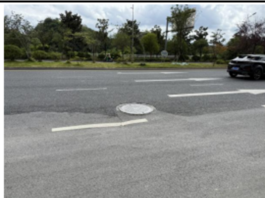
1 号化粪池接市政管网废水排放口
