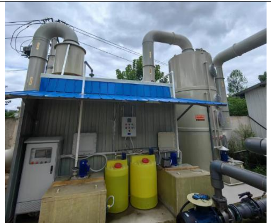
生物滤池+喷淋塔（污水处理站）
