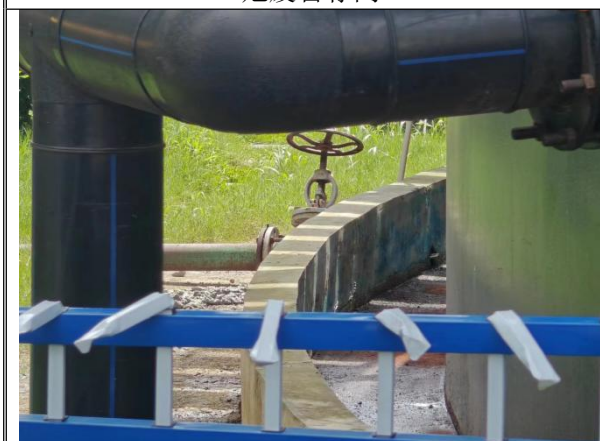
储罐区围堰
