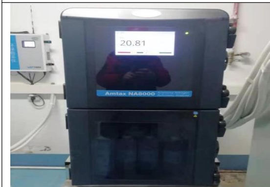
进水口氨氮在线检测仪
