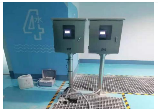
出水口 pH、悬浮物在线检测仪
