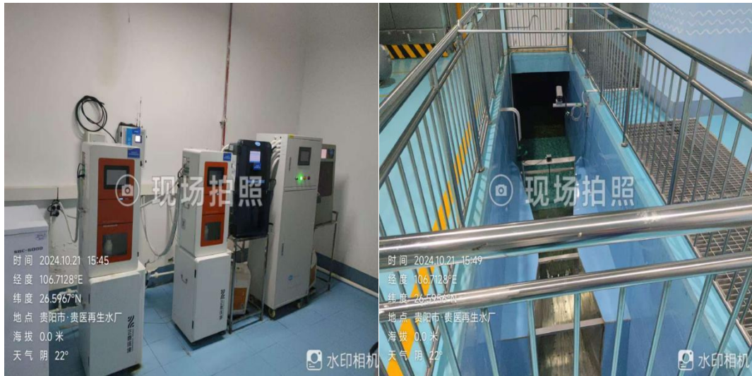
图 8-2 在线监测站房与巴式槽现场照片
