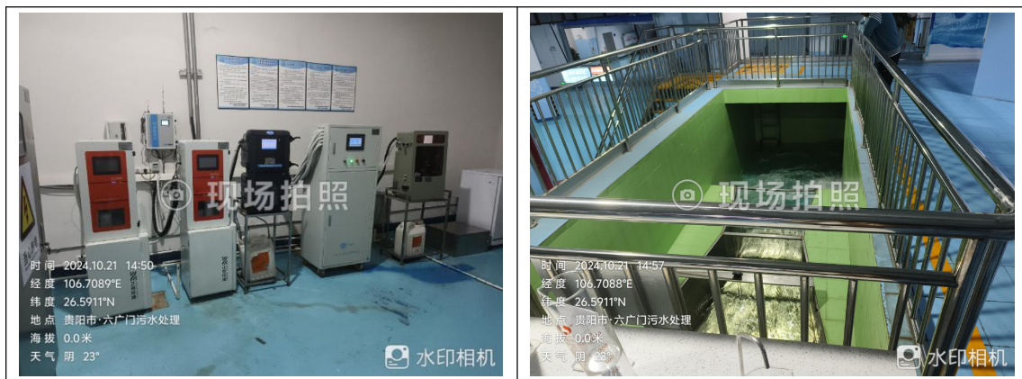
图 7-3 在线监测站房与巴式槽现场照片
