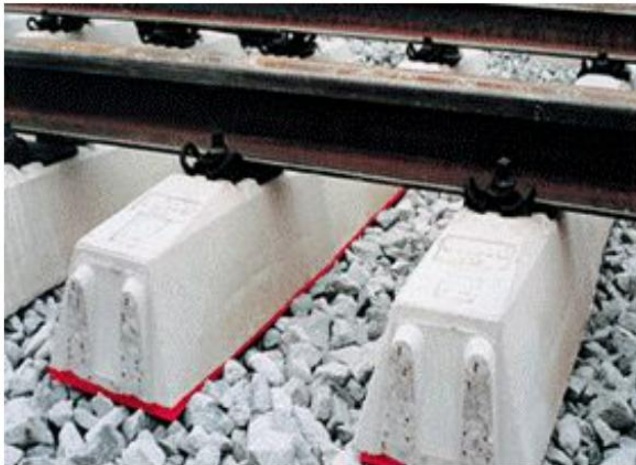
图6-2弹性轨枕有砟轨道
