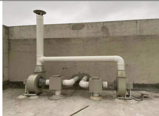
有机实验室废气处理设备及排放口
