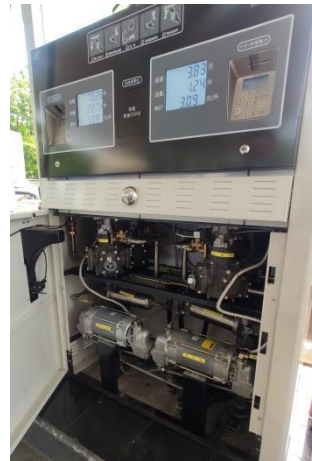
加油油气回收装置
