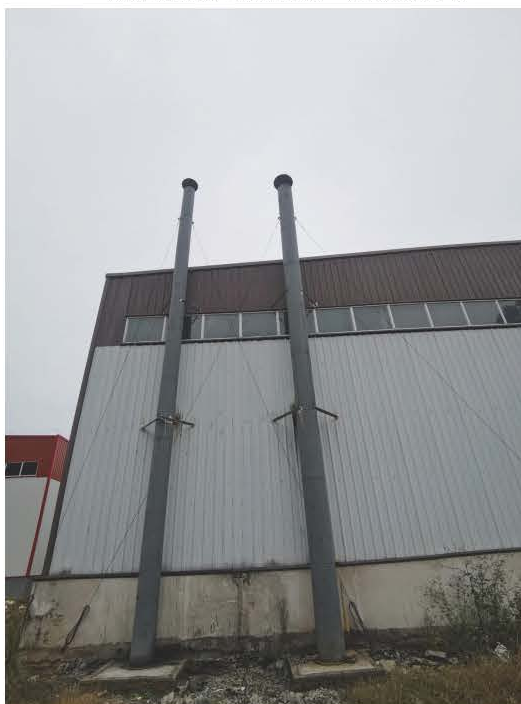
固化废气（左）及喷塑废气（右）排气筒
