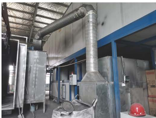
喷塑废气集气管道
