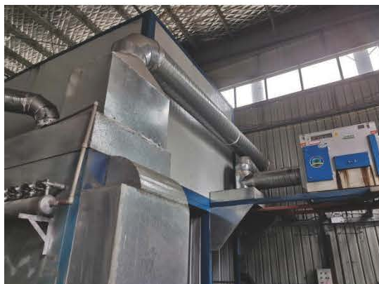
固化废气集气管道
