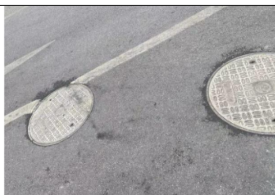
雨水池及化粪池
